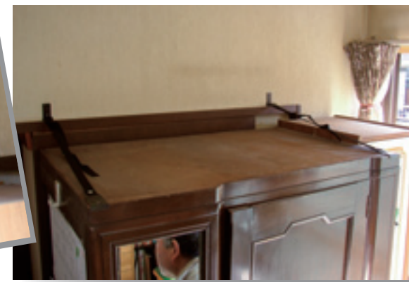
耐震ベルトを使用してタンスをバッチリ固定しました
