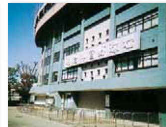
明治神宮野球場(改修工事)
