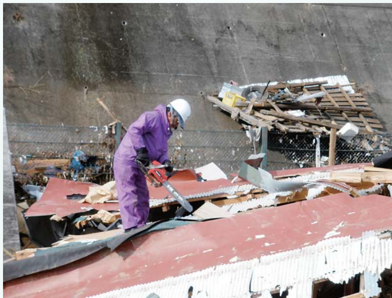
倒壊した屋根の上を切断し救助する組員 (宮古)
