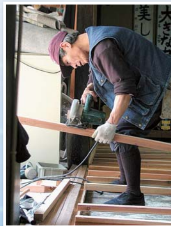
床工事に奮闘する組合員 (三宅島坪田地区)
